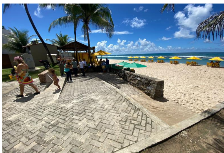
Figura 23: Rampa de acessibilidade no Barramar.
