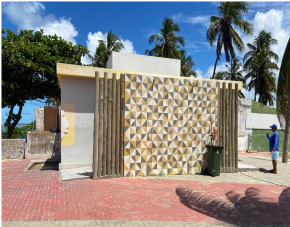
Figura 27: Banheiro público da orla.
